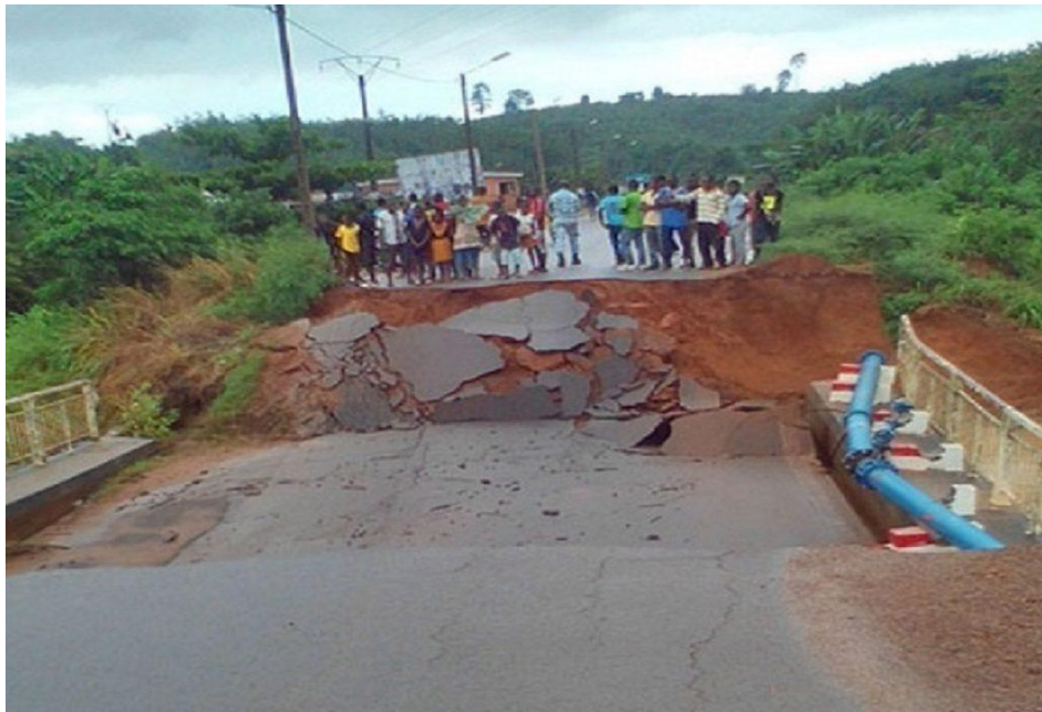
Photo 1 : Effondrement d'un pont sur la route bitumée Abidjan-San Pedro
